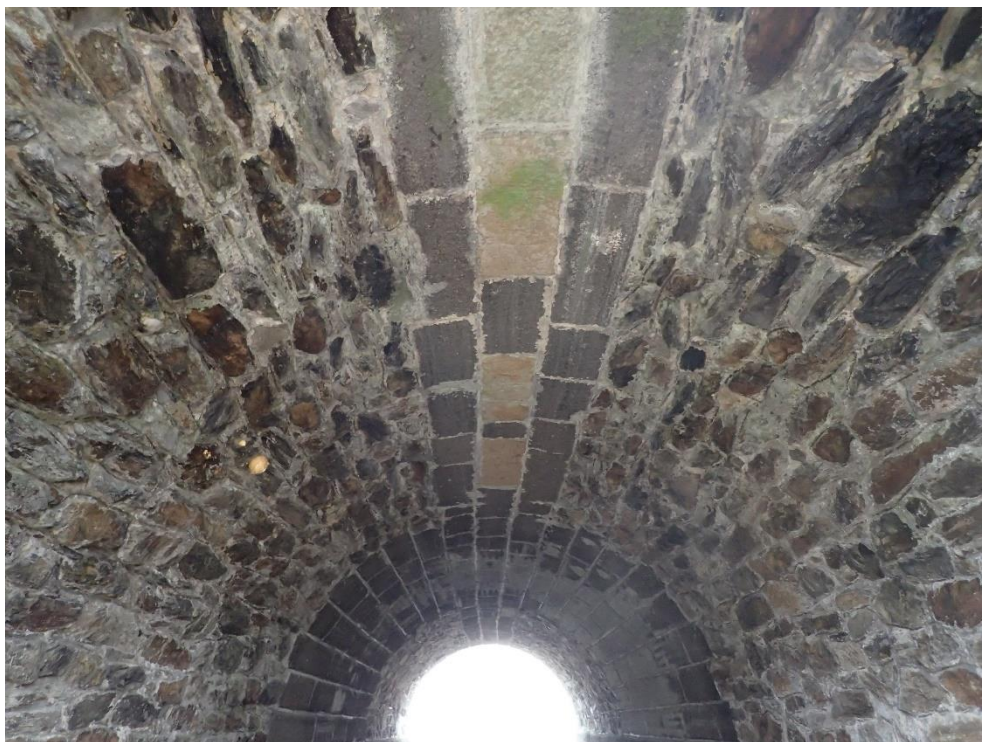
Foto 4: Místy uvolněné spárování mezi kameny v klenbě
