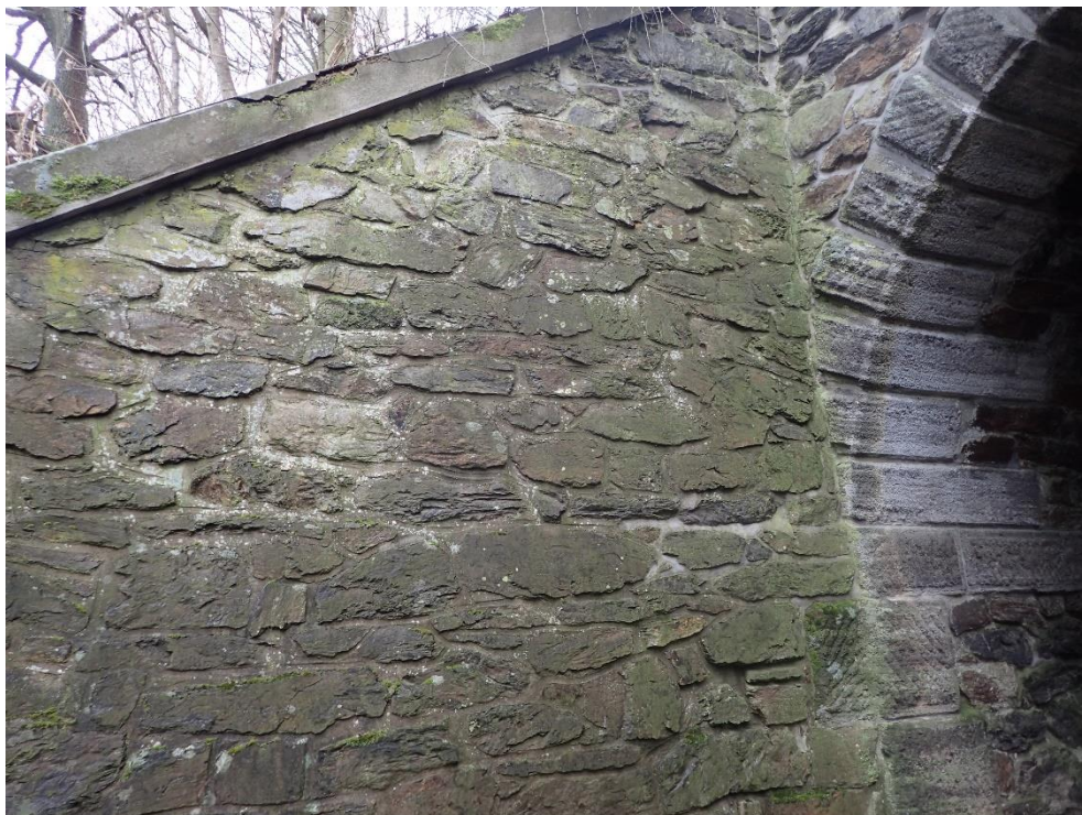
Foto 3: Degradace betonu na římse křídla
